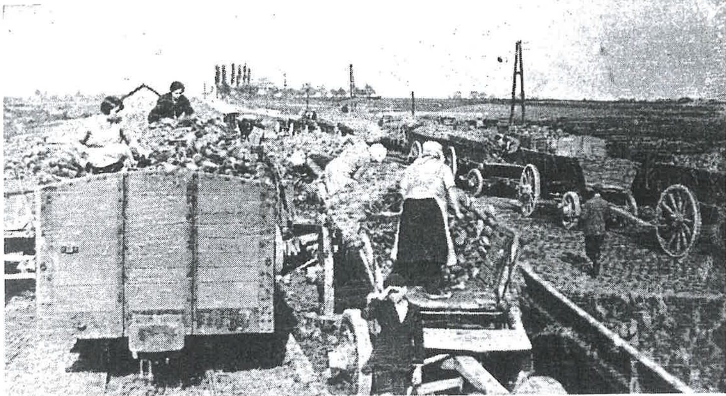
Le transbordement des betteraves sucrières à la gare vicinale
